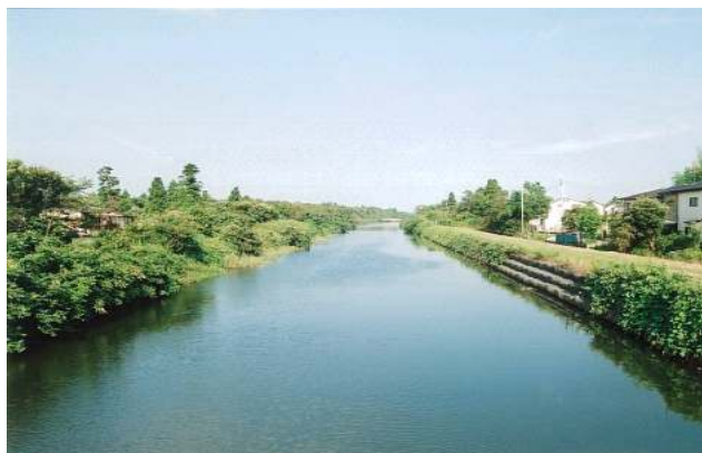
二級河川南白亀川（柳橋付近）
