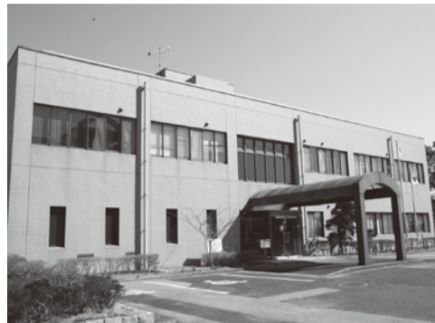
▲下水道浄化センター管理棟
