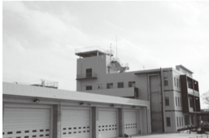
▲減額の主な要因となった「消防本部・中央消防署合同庁舎移転新築整備事業」の終了
