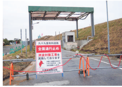
かさ上げ工事現場(中央海岸付近)
