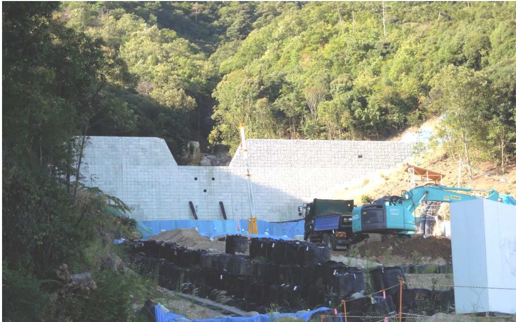
写真 2：砂防堰堤の工事現場
