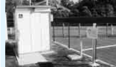
▲九十根多目的広場の屋外トイレ
