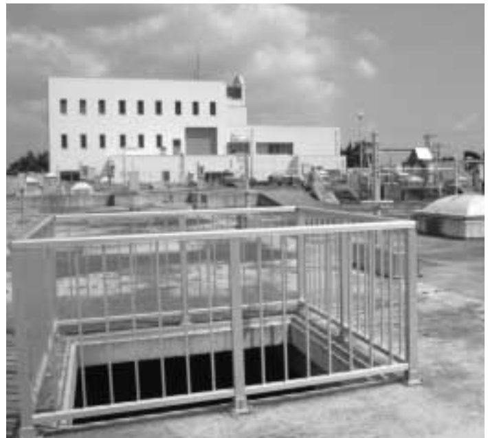
汚水をきれいにする浄化センター
