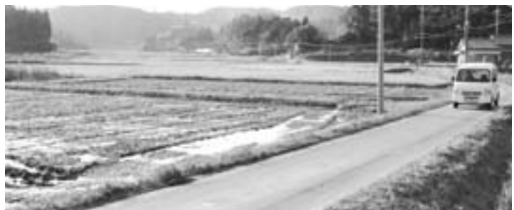
▲経営体育成基盤整備事業の工事が開始された瑞穂地区
