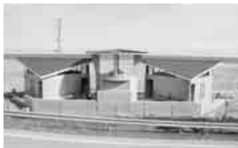
▲白里中央海岸に完成したシャワー付きのトイレ
