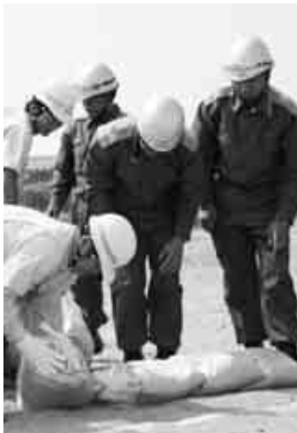
▲「地域を水害から守る」強い意識で土のうを積む
