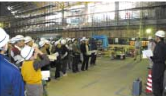
内装工事が進められているメインアリーナ
