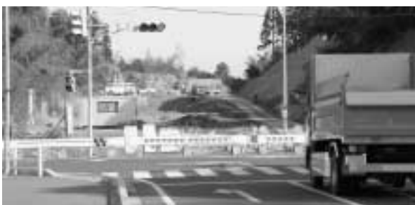
2期事業で一部工事が進む県道バイパス(宮谷地区)
