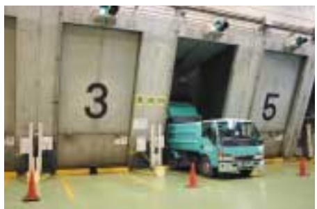
▶ごみ投入扉からごみピットへ
