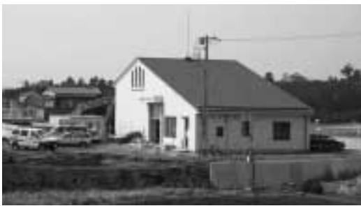
▲稼働間近の長国排水機場
