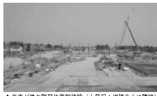
▲工事が進む町民体育館建設(上貝塚:増穂北小に隣接)
