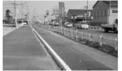
▲着々と進む国道128号バイパスの4車線化
