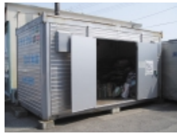
役場・中部コミュニティセンター・白里出張所に設置のリサイクル回収倉庫
