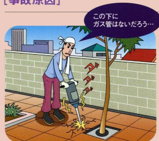
ガス事業者に事前照会を行わず、施工範囲内にはガス管が埋設されていないと思い込んでしまいました。電動工具でコンクリート舗装の壊し作業を行い、誤ってガス管を損傷させたことによります。
