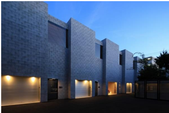
耐久性の高い石材を建物の外壁に用い、重厚な雰囲気を出している例
