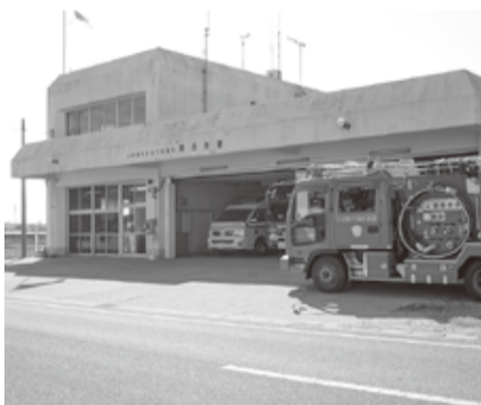
地域防災の拠点である南消防署
