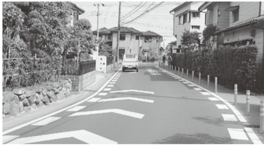
▲本事業で整備された市道(仏島地内)
