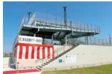
●津波避難タワーが完成
