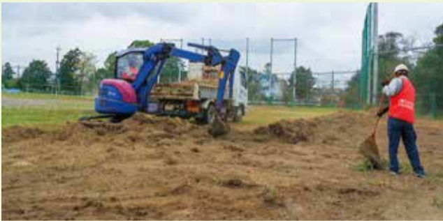
▲重機を使ったグラウンド整備
