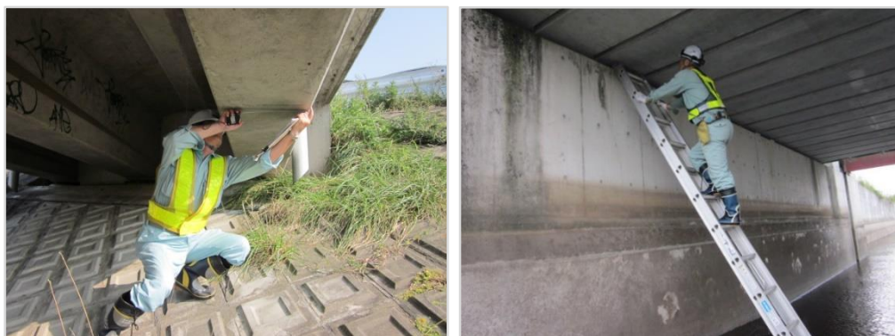
定期点検状況
