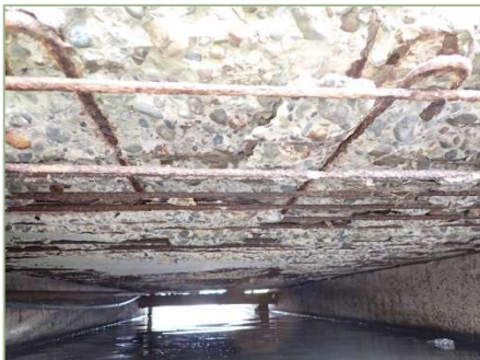
No.46_無名橋(99)【健全性Ⅲ】 （主桁）剥離・鉄筋露出
