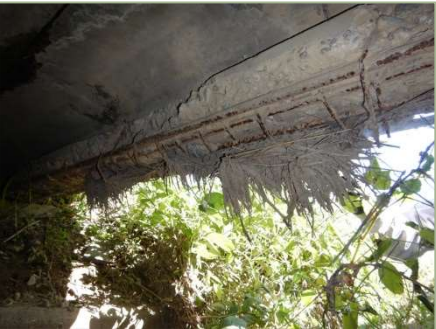
No.60_無名橋(80)【健全性Ⅲ】 （主桁）剥離・鉄筋露出
