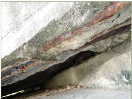
No.2 道塚橋【健全性Ⅲ】 （主桁）剥離・鉄筋露出
