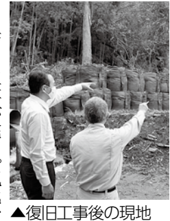
▲復旧工事後の現地
