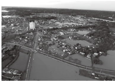
▲令和元年10月25日の大雨による被害
