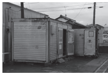
▲リサイクル倉庫
