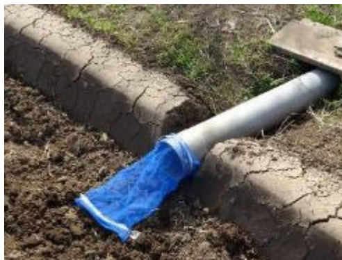
取水口への網の設置
