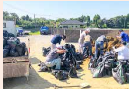
▲土のう作りの様子
