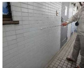
「外部（外壁）」調査の様子
