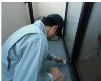
「外部（バルコニー）」調査の様子
