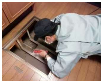
「土台・床組、基礎」調査の様子
