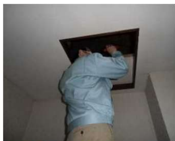
「小屋組・梁」調査の様子
