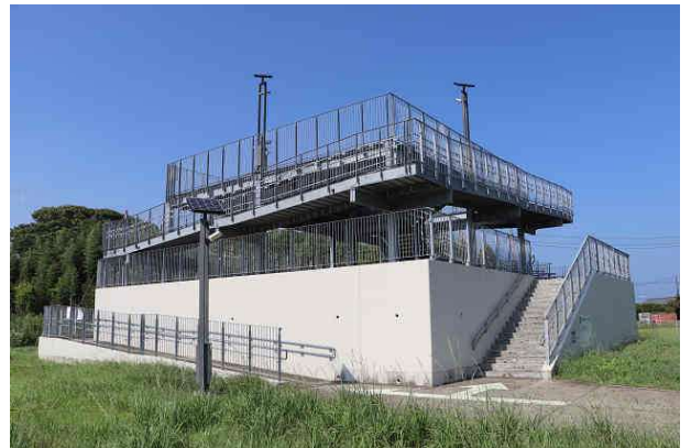
津波避難タワー
