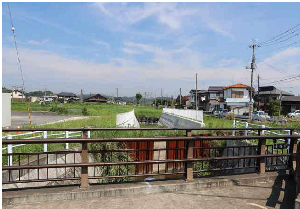
金谷川の河川改修
